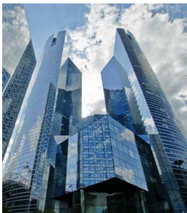
Trụ sở của Société Générale hiện đặt tại Tháp Société Générale là một tổ hợp nhà chọc trời ở khu La Défense, phía Tây Paris, Pháp
